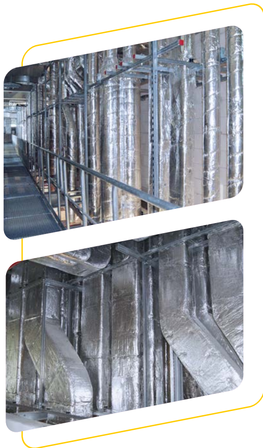
Isolierung von Rohrleitungen
