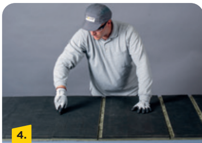
4. Wiederverwendbaren Plattenrest abtrennen
