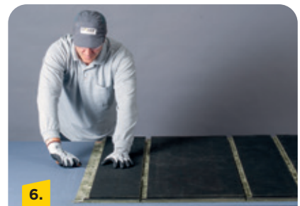
6. Mit dem Messer Mineralwollreste von der Überlappung entfernen
