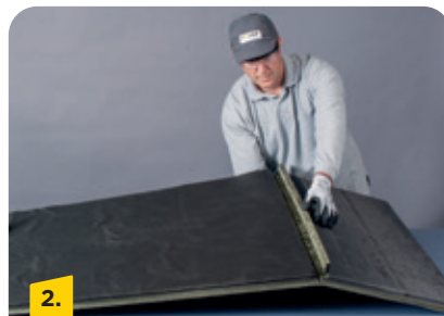
2. Herausgeschnittene Dämmstoffstreifen aus den Schnittstellen entfernen
