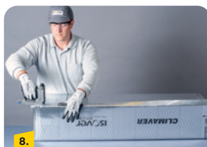
8. Den gefalteten Kanal durch Antackern der Überlappungsstreifen fixieren
