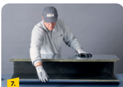
7. Lüftungskanal zusammenfalten
