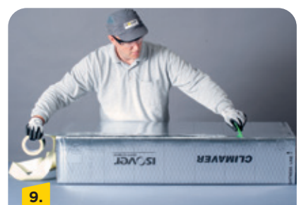
9. Stoß mit CLIMAVER Tape luftdicht kleben und mit dem Spachtel anpressen
