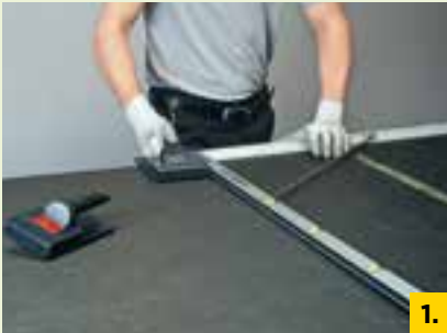
1. Stufenfalz mit CLIMAVER® Werkzeugen herstellen
