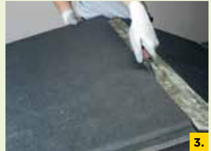
3. Wiederverwendbare Plattenreste abtrennen
