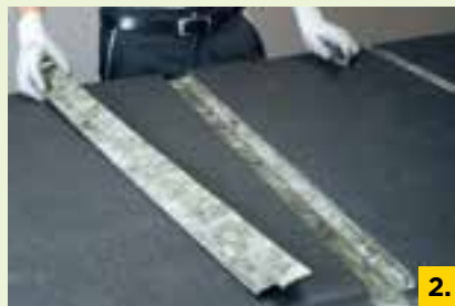
2. Verbleibende Dämmstoffstreifen entfernen
