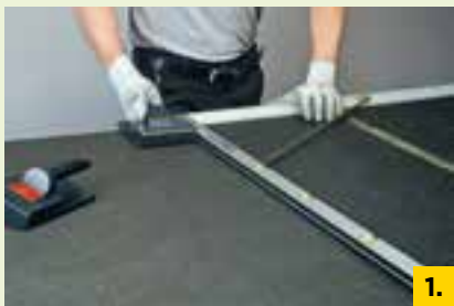
1. Stufenfalz mit CLIMAVER® Werkzeugen herstellen
