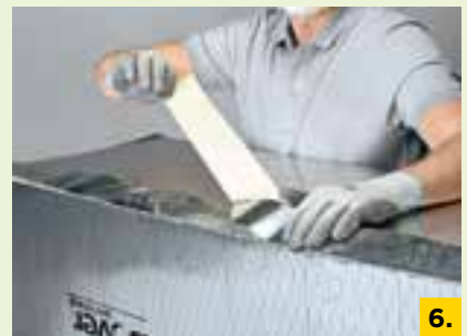
6. Stoß mit CLIMAVER® Klebeband luftdicht verkleben
