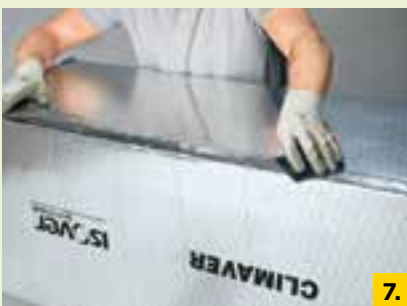
7. Klebeband anpressen – fertig ist das Kanalsegment
