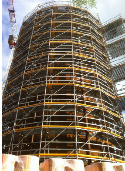
Bild 3: Eingerüsteter Wärmespeicher
