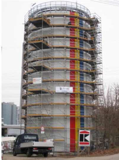
Bild 1: Ansicht Wärmespeicher straßenseitig
