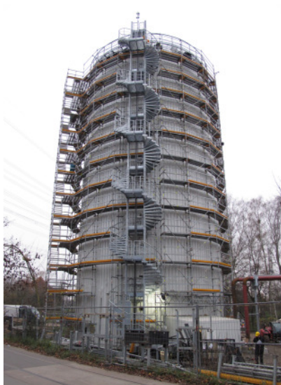
Bild 2: Ansicht Rückseite mit Wendeltreppe
